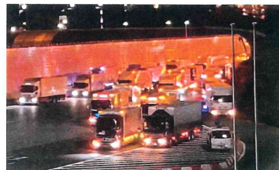
【東京本線料金所前の滞留状況】 (R2.12.23(水)23:58撮影)
